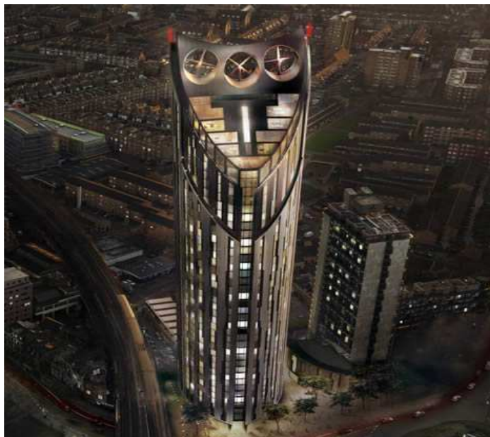
Rys. 9. Budynek Strata Tower w Londynie [7]
