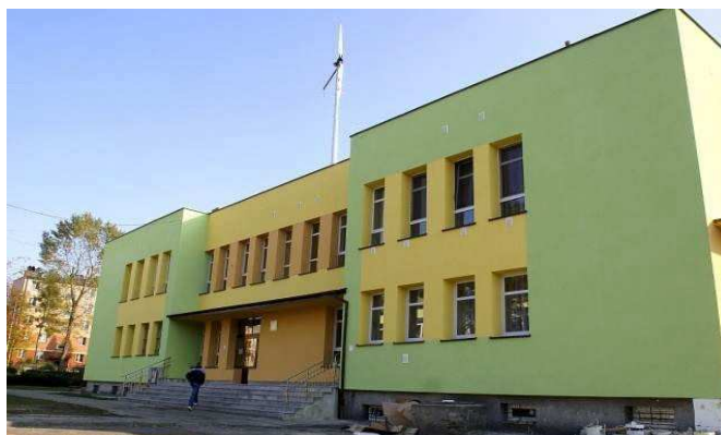
Rys. 7. Wiatrak prądotwórczy na dachu budynku przedszkola nr 6 w Jaśle [5]
