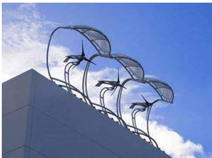
Rys. 10. Moduły turbin wiatrowych wykorzystujące wiatr opływający ściany budynku [8]
