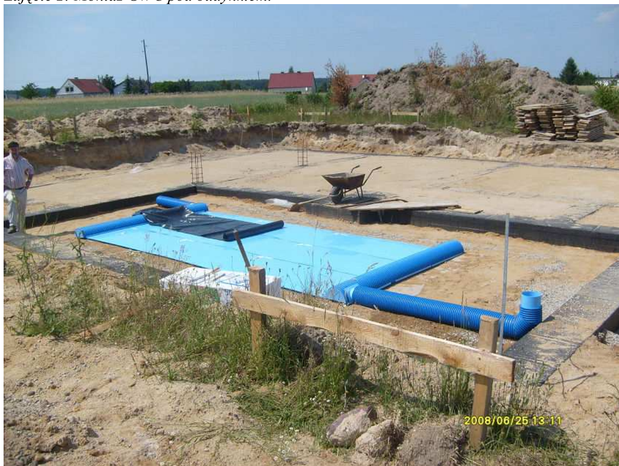
Zdjęcie 2: Montaż GWC pod budynkiem.
