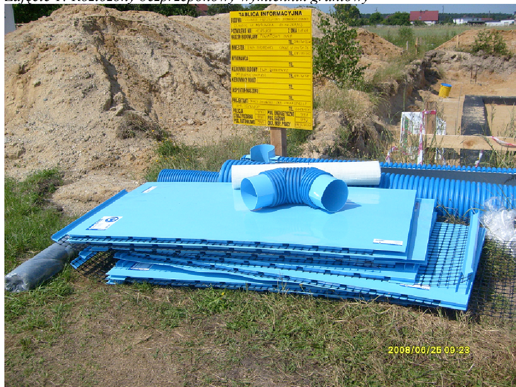
Zdjęcie 1: Rozłożony bezprzeponowy wymiennik gruntowy
