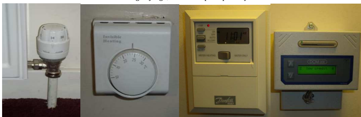
Fot. 4.2. Elementy sterujące instalacji centralnego ogrzewania zasilanych zdalaczynne, od lewej: zawór termostaticzny, termostat sterujący ogrzewaniem powierzchniowym, zegar sterujący z wyłącznikiem obwodu grzejnego, sterownik przedpłatowy
